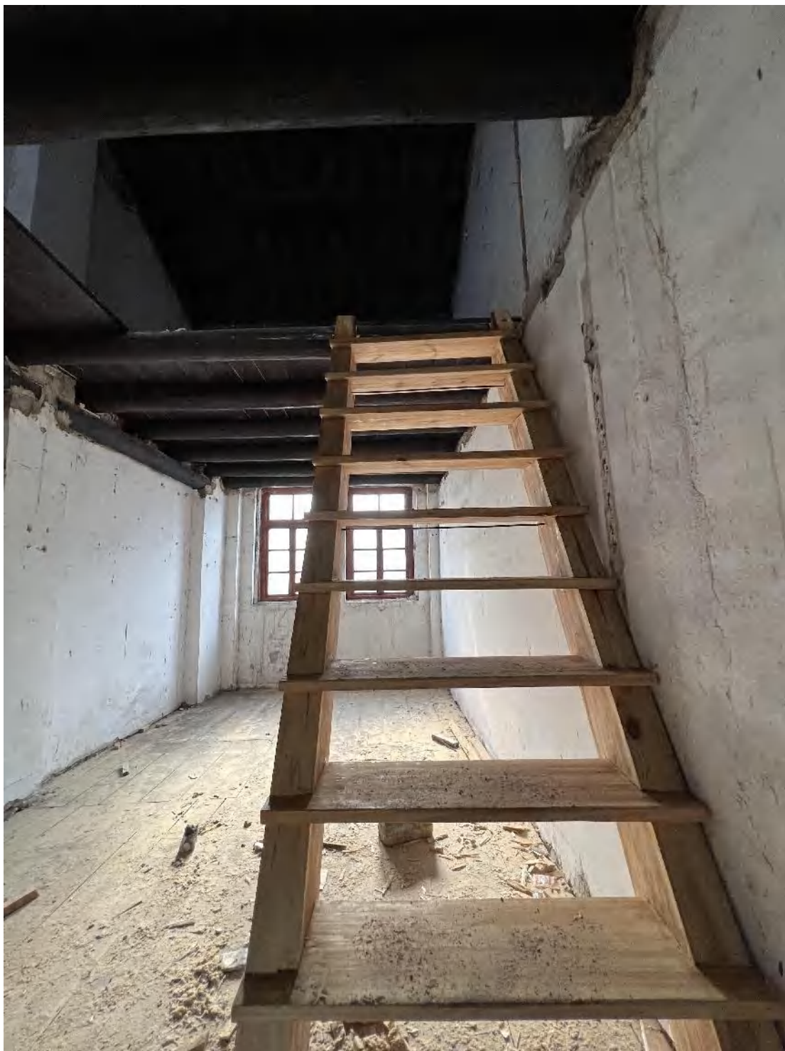
二楼上三楼楼梯
